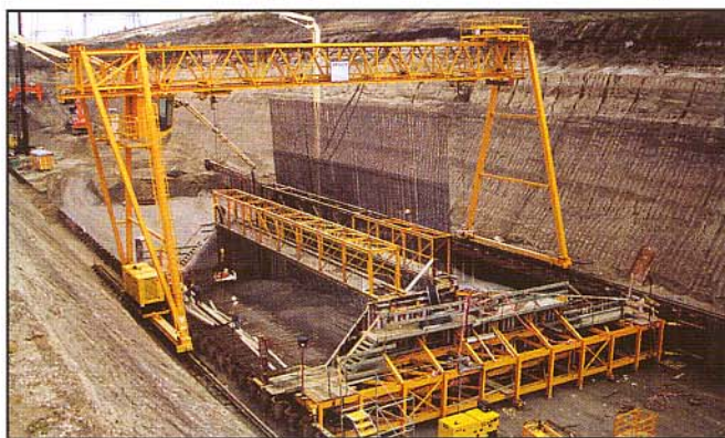
Törtvonalú zsalu és végfalzsalu mozgatása bakdaruval. A 24 m széles alaptest mindkét oldalának zsaluzataként 1-1 szádfal szolgált.
