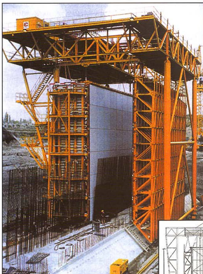
Bakdaru a falzsalut tartó rácsos tartókkal és a felső járószinttel. Szép betonfelületet biztosít a 23 mm vastag Alkus műanyag zsaluhéj.
